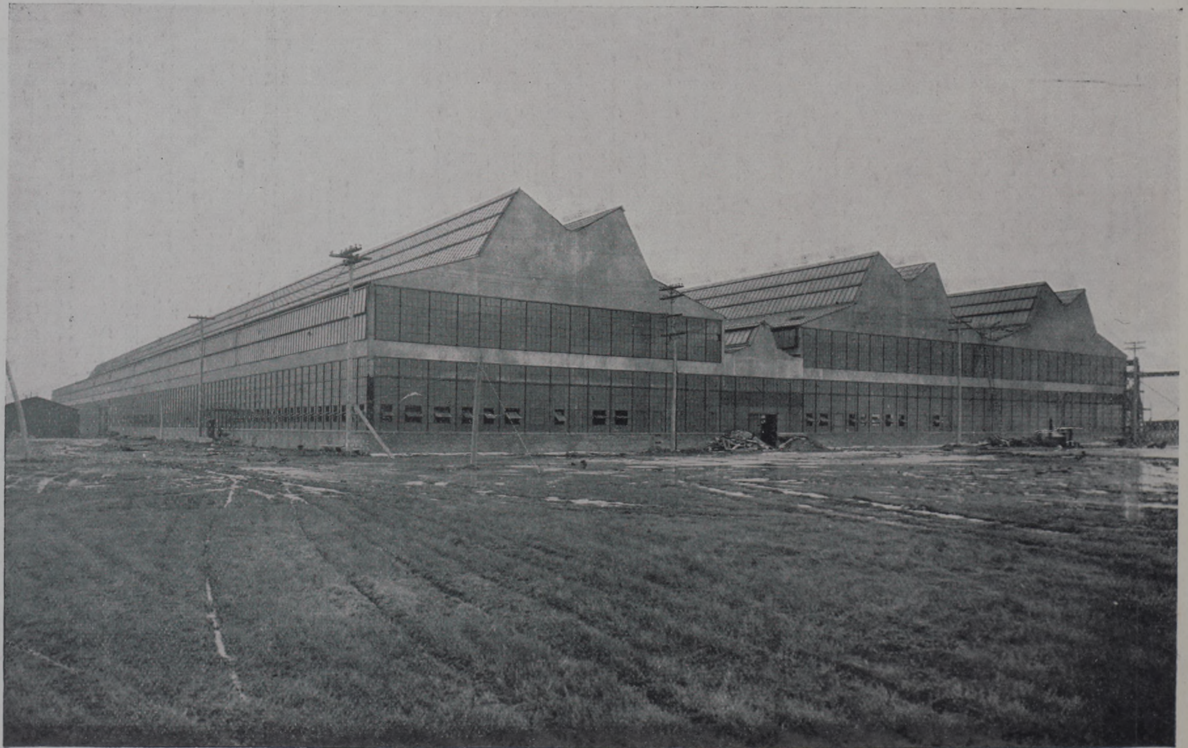
Albert KAHN. — Usine de la " Seamless Steel Tubes, Détroit
